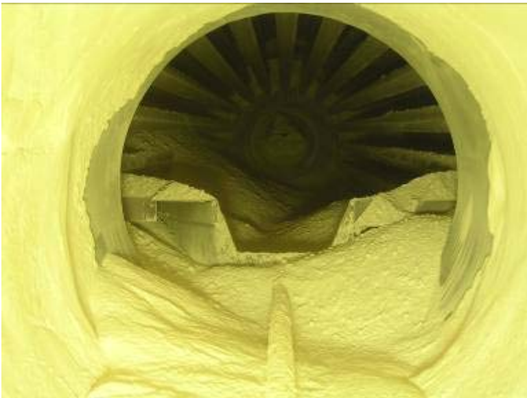
Bild 9: Släckarens utmatningshals med de ställbara utmatningsskoporna. Kalk har klibbat fast runt utmatningshalsen. Tubulären är välfylld med material efter att fastklibbat material lossnat från väggarna.
